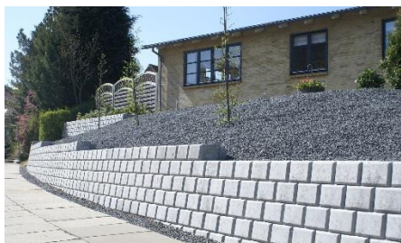
Støttemur. Det er vigtigt ved dimensioneringen at tage højde for belastningen oven for muren, f.eks. trafik eller som her jordvolden.
